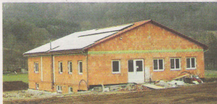
Der Rohbau des neuen Vereinsheimes steht. Einweihung im Herbst?
